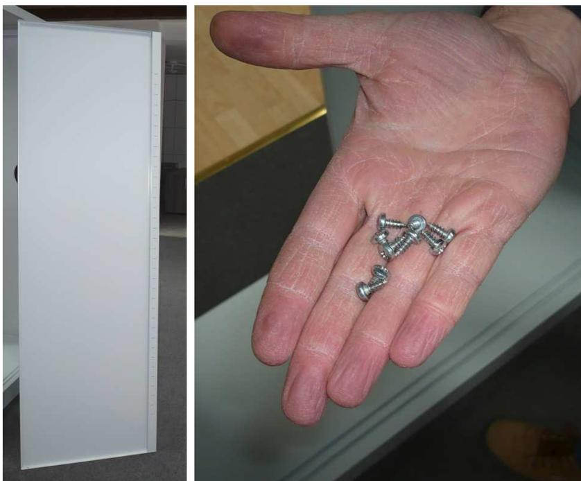
I retri sono ambidestri e le viti per il fissaggio sono delle autofilettanti.
