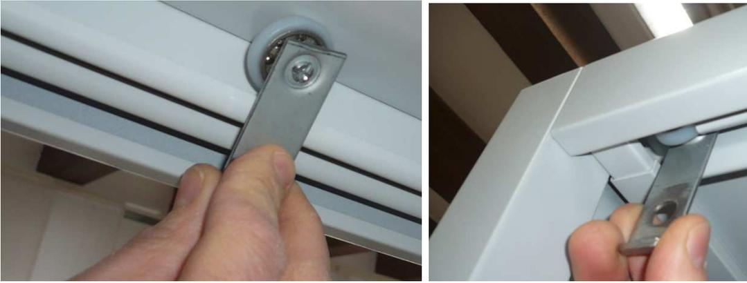
Foto a sx, posizione cuscinetti per anta sx, foro a dx, posizione cuscinetti per anta dx.
