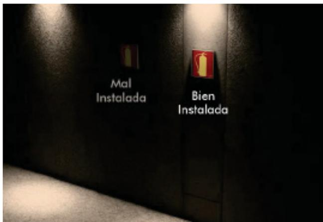
La señalización de los medios manuales de extinción se realizara siempre que sea posible en la vertical del elemento a señalar.
